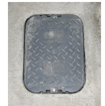
Panneau d'accès au clapet antirefoulement transparent.
