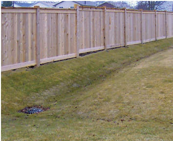
Cour arrière typique avec des rigoles de drainage.
